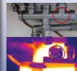
Con una cámara térmica se localiza rápidamente el punto donde la tubería está bloqueada. El problema se podrá solucionar antes de que la situación empeore.
